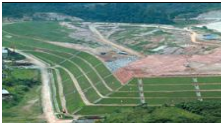
Figura 30 Aterro Sanitário da Empresa Lara Central de Tratamento de Resíduos Ltda
