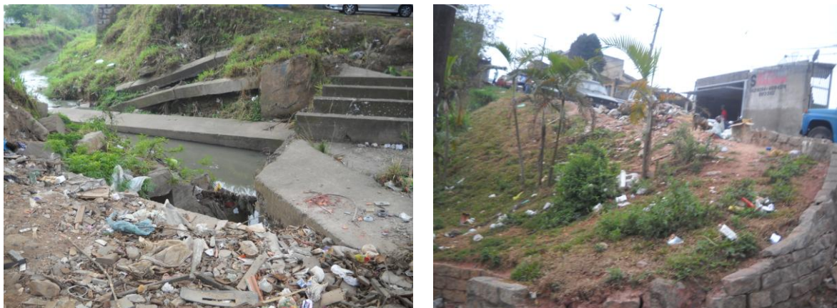
Figura 27 Locais de deposição irregular de resíduos (RCC e materiais inservíveis)
